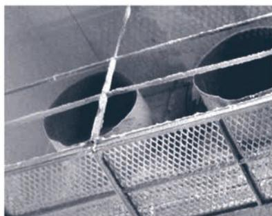
Formation de glace sur les appareils et les équipements, obstruant les conduits d'aération
